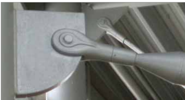
Système de compression relié à un gousset soudé
