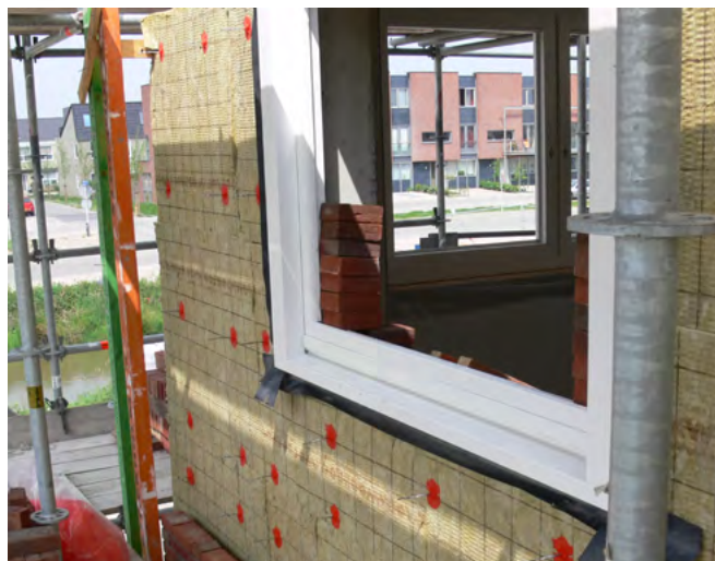
Ancrage pour façade avec UNI-CLIP
